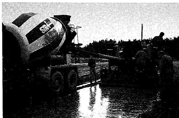
Provläggning i trakten av Åtvidaberg. Ombyggd asfaltläggare och rotorbil med slas.
